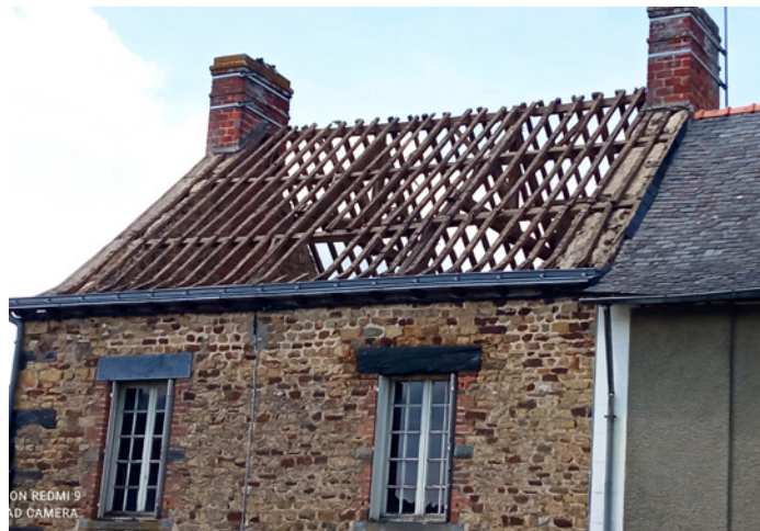
La Maison 34, Rue Sipia au début des travaux en Mai 2023
